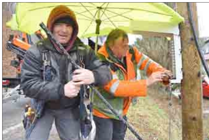
Volker Riethmüller (links) und Frank Horack von einer Spezialfirma aus Hessisch Lichtenau beheben den Schaden an der Oberleitung nach Schierschwende.
